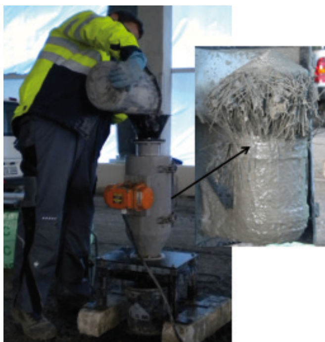
Bild 7: Stahlfaserausählung mittels Faserauszahlgerät
