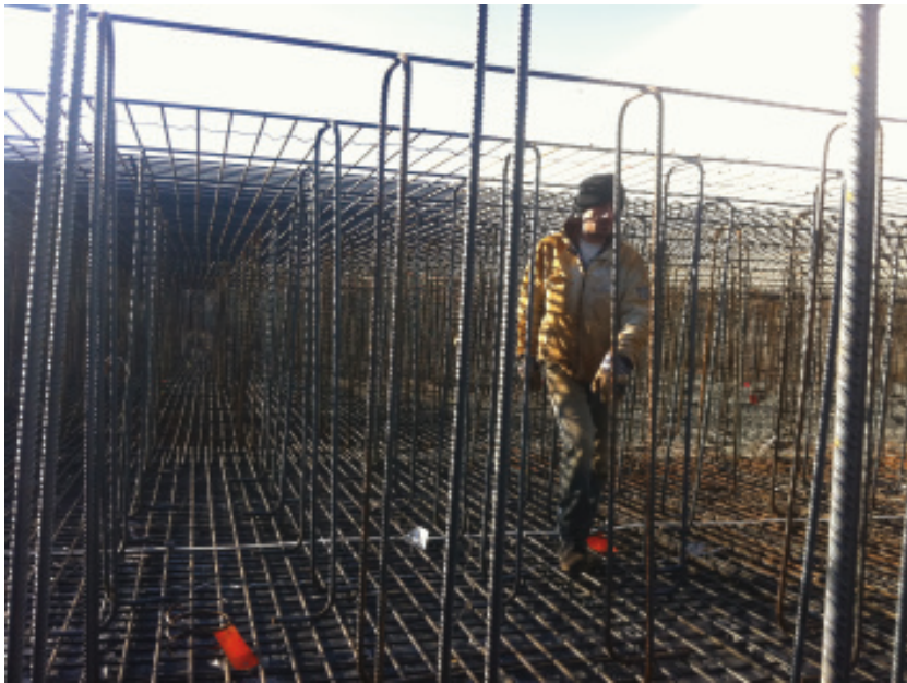
Bild 3: Bewehrte Bodenplatte
