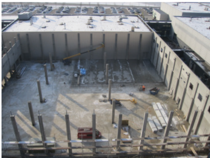
Bild 6: Halle im Rohbau
