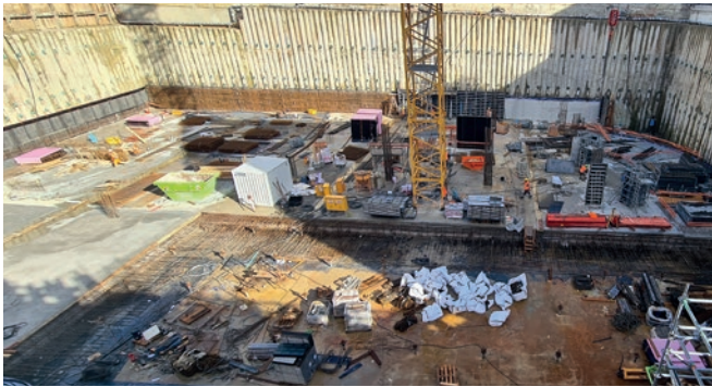
Bild 4 Ausführung der Fundamentplatte
