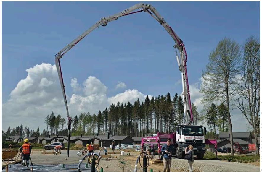
**Bild 5** Problemloses Pumpen des Stahlfaserbetons
