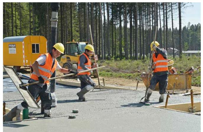
**Bild 3** Betoniervorgang der letzten Bodenplatte des Großprojekts
